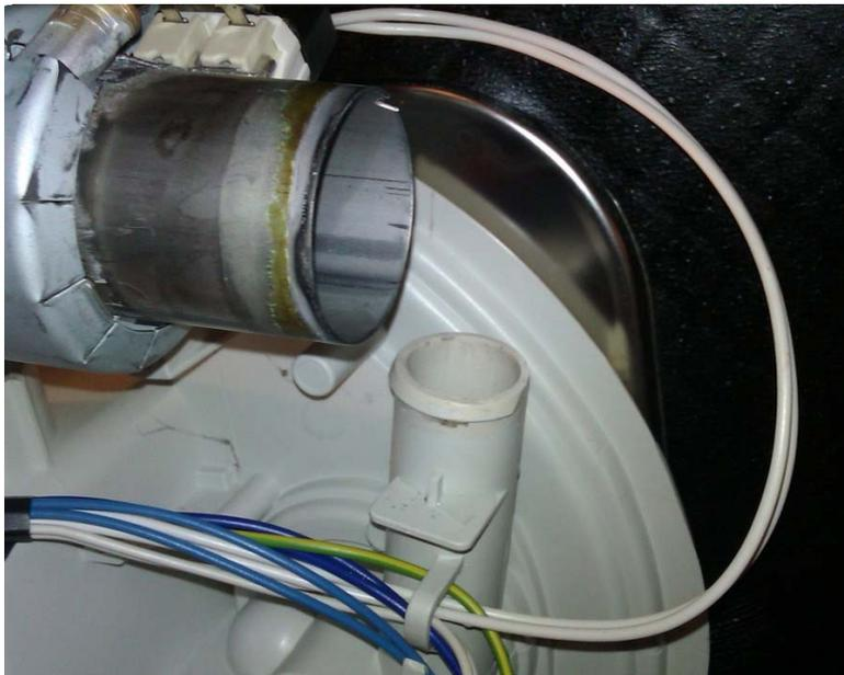
**Bild 17:** Freie Zulauf- (links) und Ablaufrohre (unten) nach Entfernung der alten Pumpe
