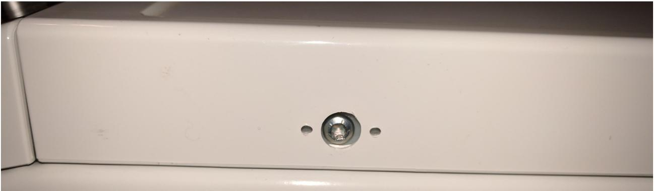
Unter diesen Abdeckungen befindet sich eine Tx20 Schraube, diese entfernen.
